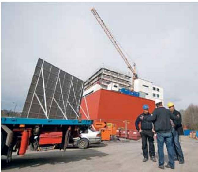
Med en god leiekontrakt på plass, begynner byggingen.
